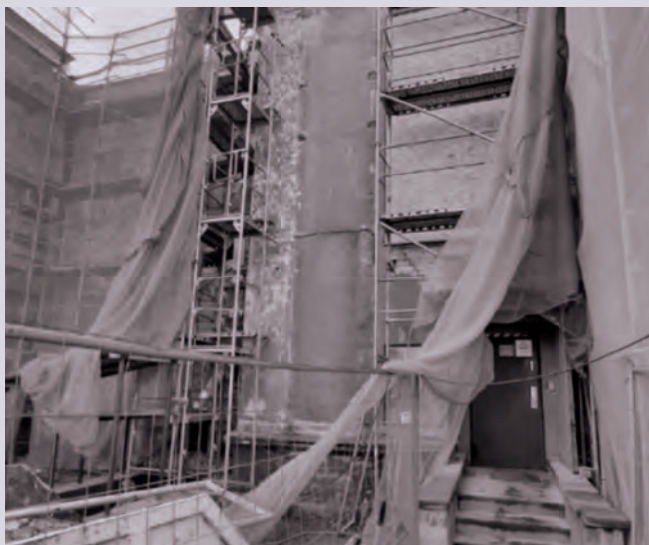
Remontdarbi. Foto: IDB
